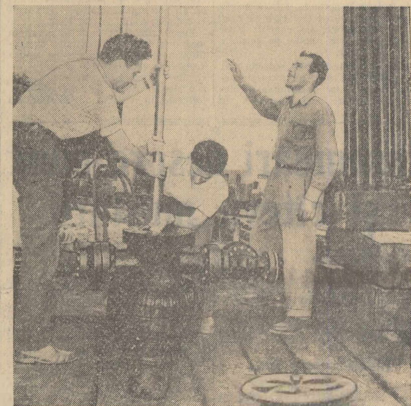
Aspect de la una din sondele schele Boldești în timpul folosirii procedurii de investigare radioactivă a structurilor petroliere.
