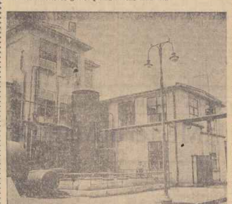
În cadrul combinatului a intrat în funcțiune anul trecut o fabrică de policlorură de vinil, prima instalație industrială de acest gen din țară (clădirea al III-lea). În secția de autoclave a acestei fabrici (clădirea al IV-lea) se face polimerizarea monomerului.
