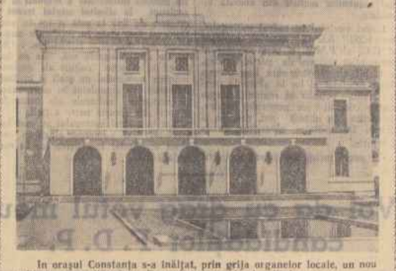
În orașul Constanța s-a înălțat, prin grija organelor locale, un nou edificiu care adăpostește Teatrul de Stat din localitate.
