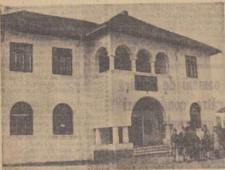
Printre realizările din ultimii ani ale sfaturilor populare din regiunea Pitești se numără și căminul cultural „Flacăra” din comuna Drăgan. În clădire: Căminul cultural „Flacăra” din comuna Drăgan, unde funcționează și școala elementară de 7 ani.
