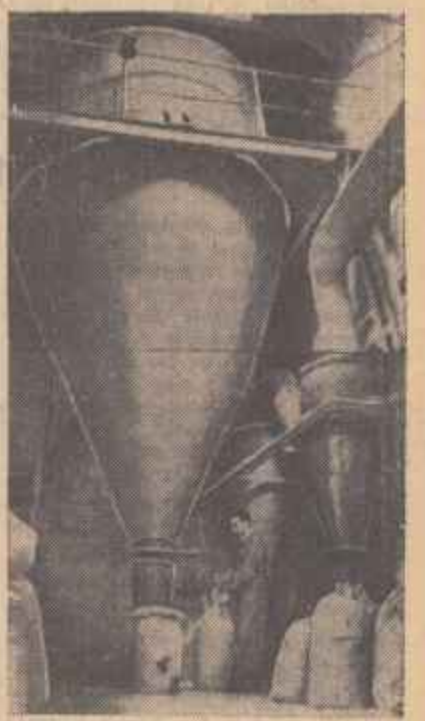
In cliseu: Instalația de fabricare a prafului de săpun „Sin”.
