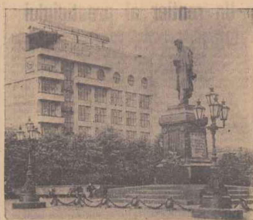
În Piața Pușkin din Moscova se înalță clădirea ziarului „Izvestia”.
