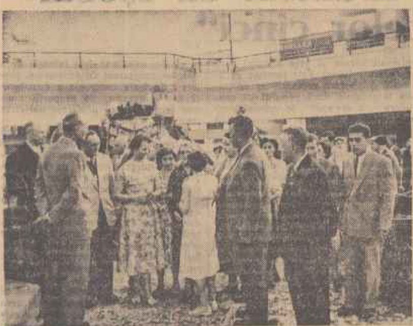
La Halde Centrale
