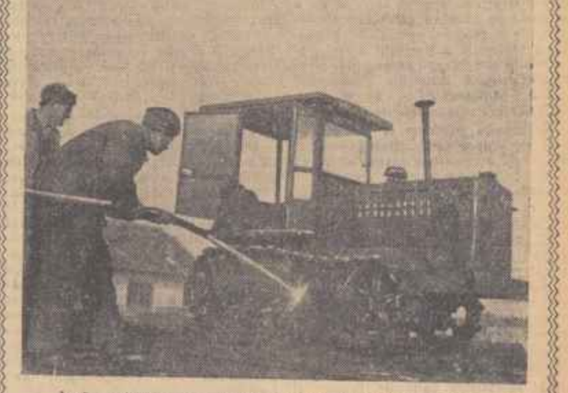
Încă un tractor va intra în reparații. Înaintea de a fi demontat el este spălat cu ajutorul unei pompe confecționată din resurse locale, care reduce de 10 ori timpul de spălare.
