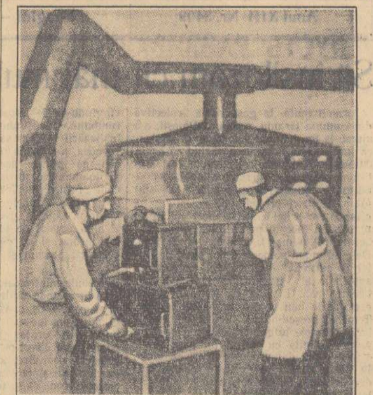
În titlul de sudură electrică „E. O. Paton”. Laboranții institutului L. M. Bogacek și B. G. Medvedovski verifică calitatea sudurii cu ajutorul unui izotop radioactiv al sulfului.
