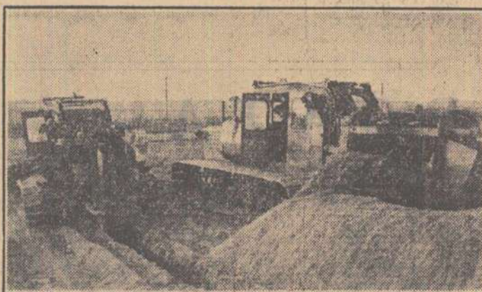
Uzina „Krasnii eskavatori” din Kiev produce în serie puternicele escavatoare „ET-141”. Într-o oră un asemenea escavator sapă 140 m. de șanț. În clișeu: Escavatoarele „ET-141”, trecînd ultima probă înainte de a fi trimise spre șantiere.
