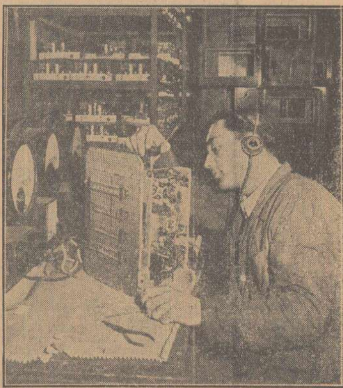
Fabrica „Radio Popular” d'n Capitală a început să producă un nou tip de aparat de radio marca „Simfonia”. În clădire: Tov. Gheorghe Radu de la secția de montaj a fabricii, face reglajul de înaltă frecvență unui aparat de radio „Simfonia” înainte ca aparatul să părăsească fabrica. Foto AGERPRES
