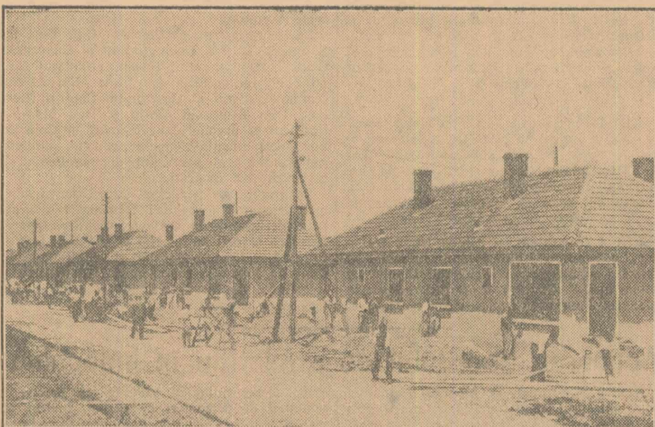
La zece ani de la eliberare, patria noastră este astăzi un vast șantier. De la un capăt la celălalt al țării, alături de vitătoarele fabrici și uzine, pretulindeni se înalță noi construcții de locuințe. În clădire: Apartamentele în construcție la șchea Dragomirești. Fiecare apartament se compune din două camere, baie, bucatărie, dependințe, etc. și este dotat cu instalații de încălzire cu gaze. Foto: AGERPRES
