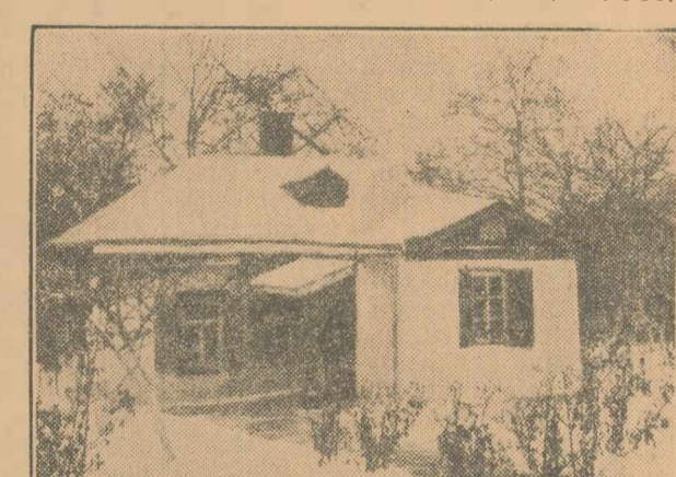
Casa în care a copilărit Cehov, azi transformată în muzeu.
