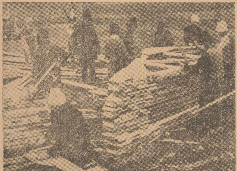
La Gospodăria Agricolă Colectivă Live dea se lucrează la construirea unei remize care va fi gata la 21 Decembrie
