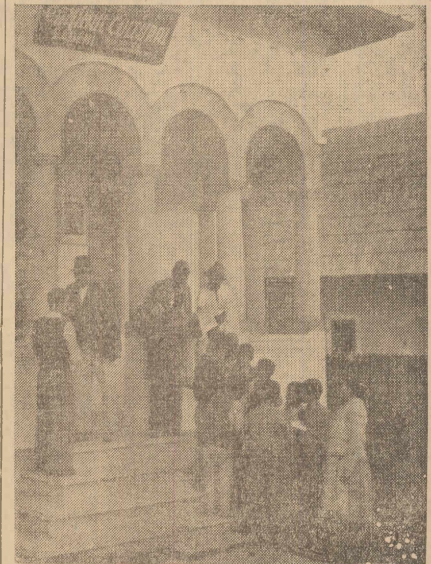
Noua clădire a Căminului cultural din comuna Băbeni-Argeș
