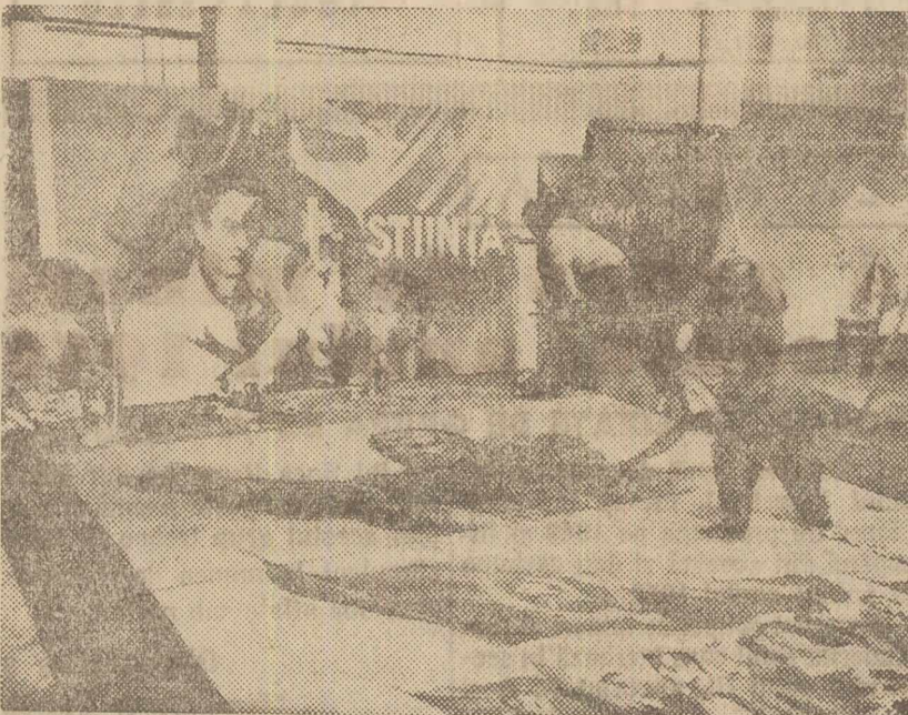
La „Drum nou” se lucrează peste 100 de panouri
