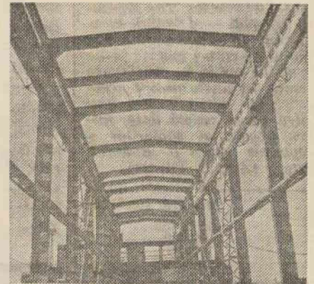
În construcție, una din halele oțelăriei „Katowice” care va furniza — în prima etapă — 4,5 mil. tone de oțel pe an
