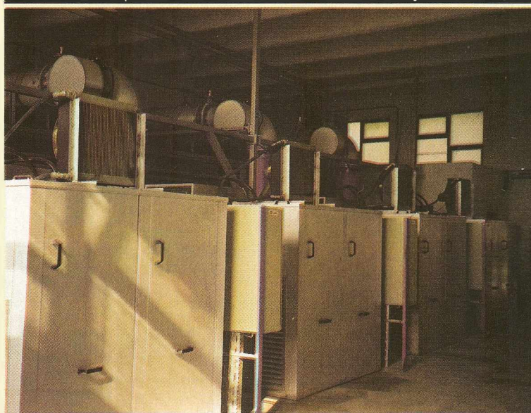
Stațiile de pompare sunt utilizate cu aparatură daneză modernă
