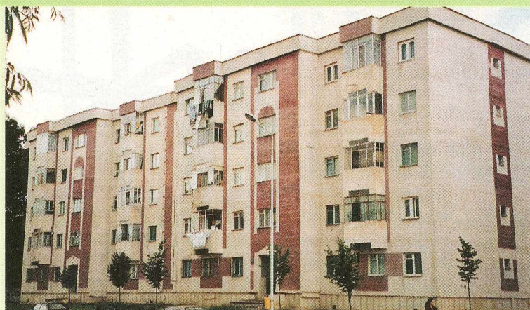
Blocul 611, unde a avut loc prima reabilitare a agentului termic
