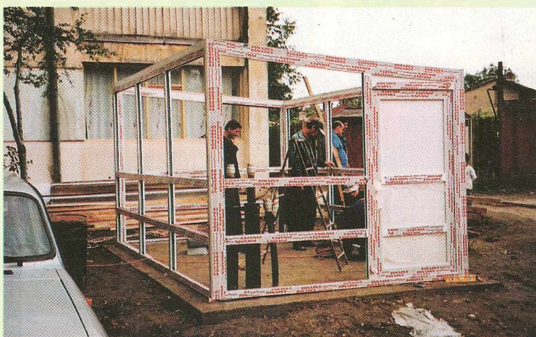
Se muncește din greu la sediul unui nou punct termic
