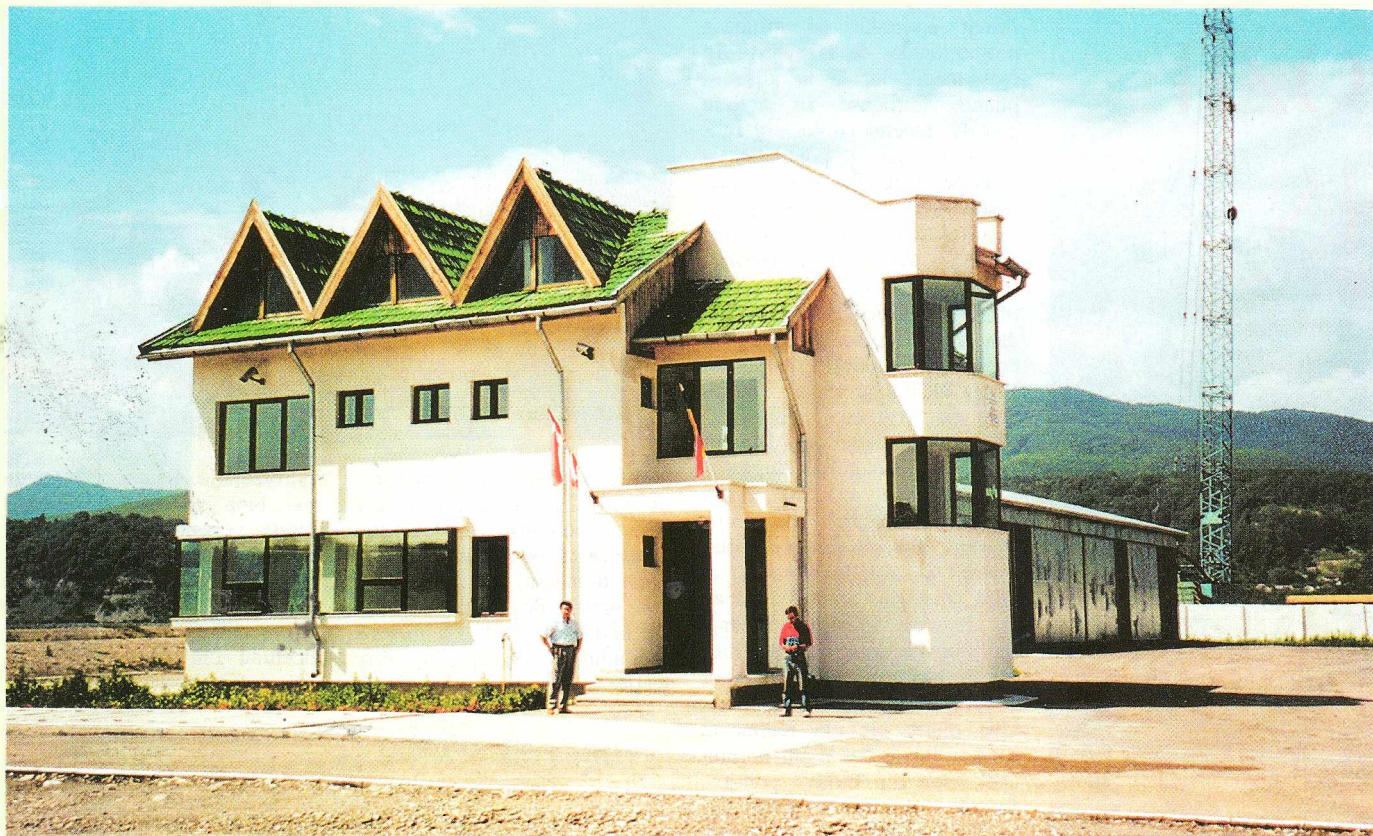
Sediul depozitului ecologic de la Piatra Neamț
