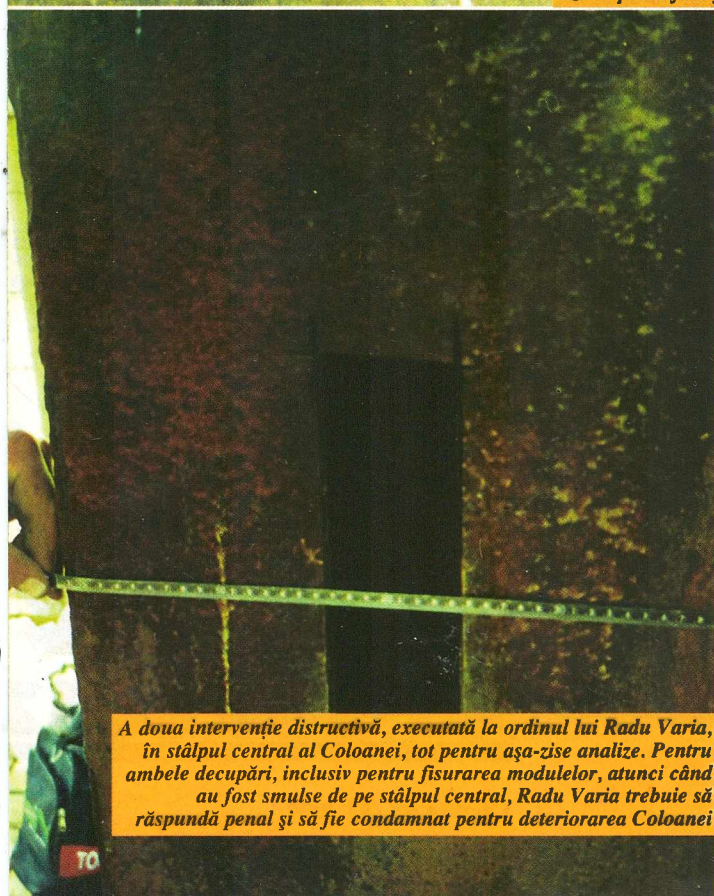
O decupare din modulul cu nr. 16, comandată de Radu Varia, pentru a se analiza compoziția fontei din care au fost turnate modulele. O astfel de analiză se putea face fără această intervenție distructivă
