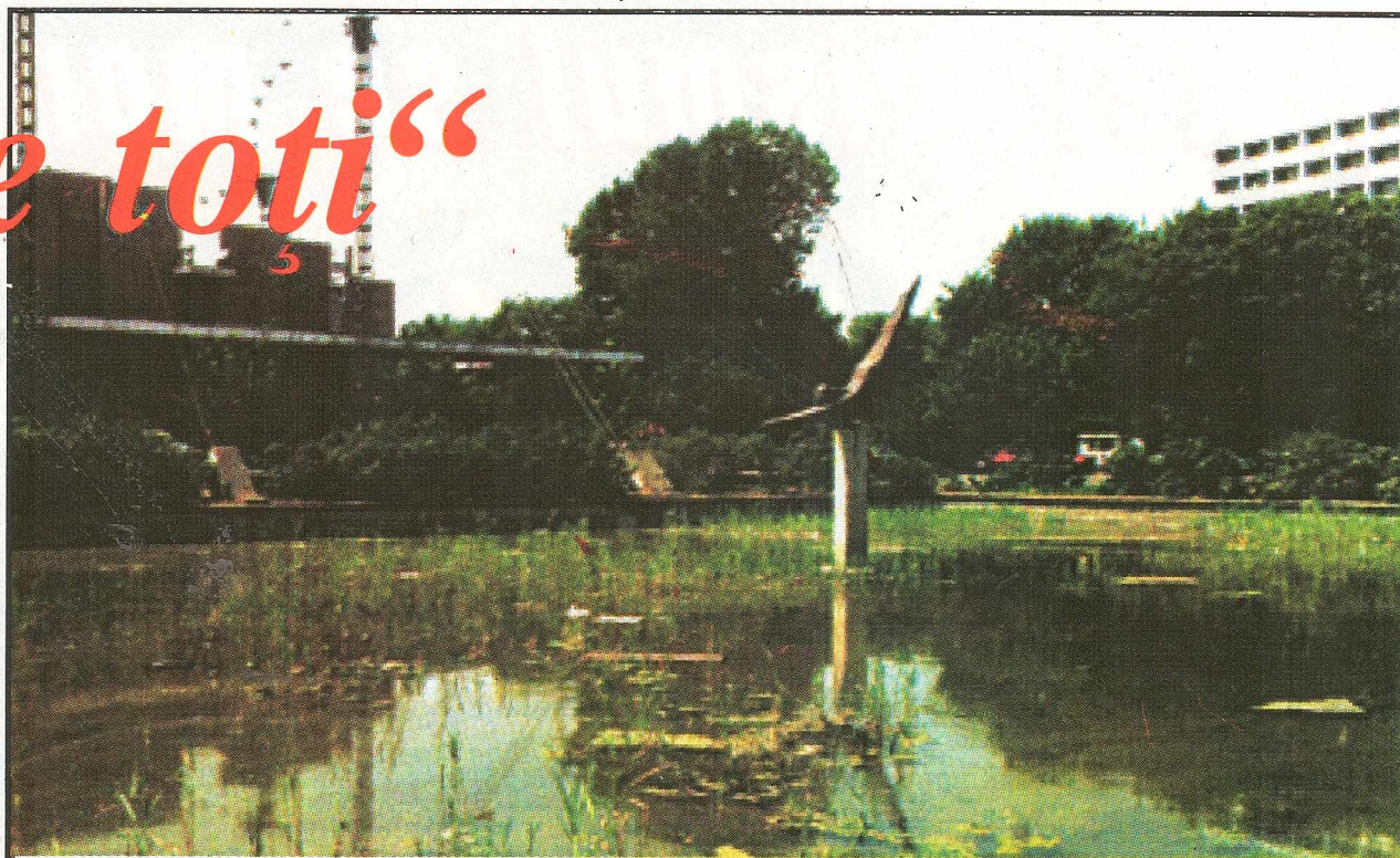
Așa arată bazinul de pe faleza din fața Teatrului de Vară din Mamaia, loc de desfășurare pentru nenumărate șușe și care, de anul acesta, a rămas de tot fără copertină
