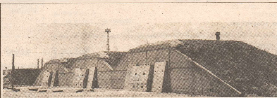
„Iglu-uri” ce servesc drept depozite pentru arme nucleare și loc de stocaj pentru uraniu și plutoniu, în care intrarea este imposibilă fără a se deplasa blocurile de beton ce obturează intrările
